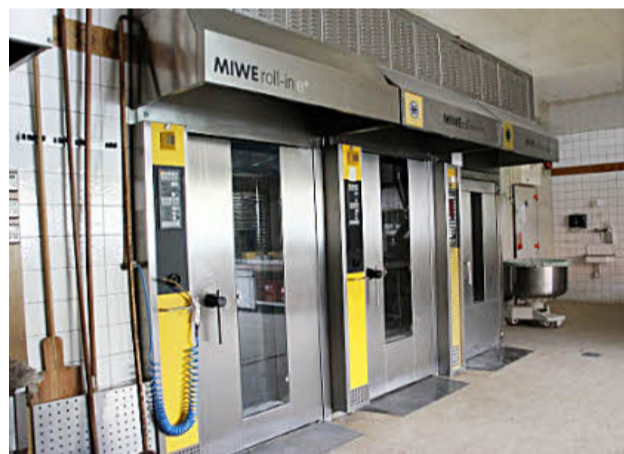
In der Bäckerei von Michael Oppel (oben) gibt es viele Stromfresser: Die Theke (oben), der Backofen (links) und die Rührmaschine (rechts). Mit dem Trafo spart er nun Energie.
